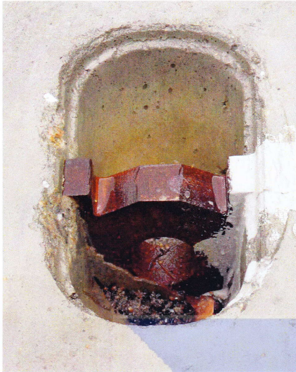
Obr. 6.5 – Kotvy pro zajištění stability vyprošťovacího vozidla (sil. I/7)
